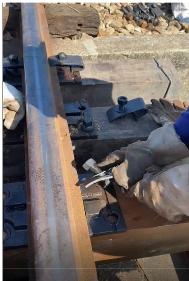
Hình B.4 - Đặt đệm thép và bu lông cóc nhíp
