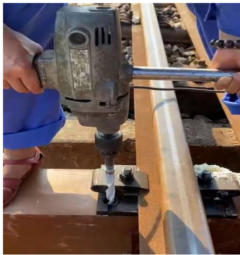
Hình B.5 - Khoan tạo lỗ đinh xoắn
