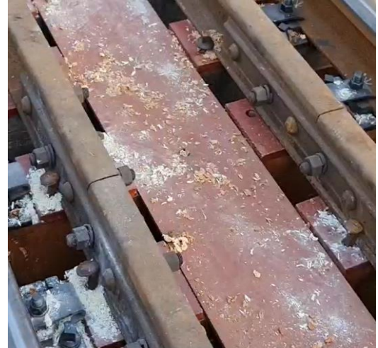
Đóng chặt đinh đường
